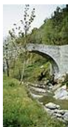
Casteldelci, Ponte Vecchio
