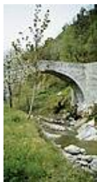
Casteldelci, Ponte Vecchio
